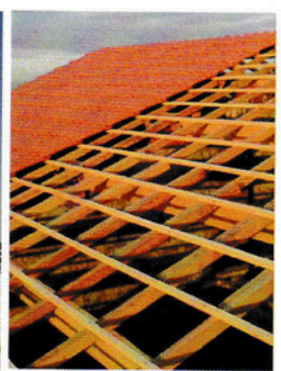
POSE TUILE TB 12 SUR CHARPENTE EN BOIS
