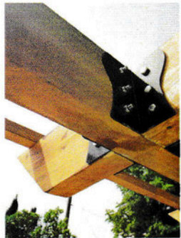
CHARPENTE EN BOIS
