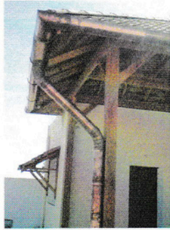
GOUTTIERE ET DESCENTE D'EAU PLUVIALE EN CUIVRE ROUGE
