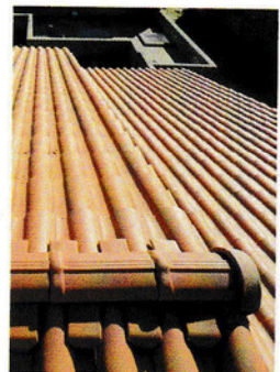
POSE TUILE TB 11 ET ACCESSOIRES
